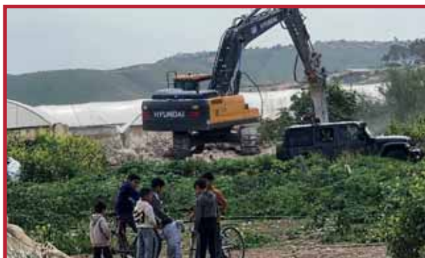
19 février 2026. Démolition d'une habitation dans le village d'Ain al-Bayda dans le Nord de la Vallée du Jourdain par les forces d'occupation.
